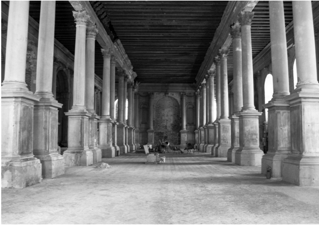
Documentation of column bases, Scuola Grande della Misericordia Venice, Italy
